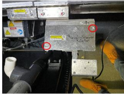
2. Draufsicht Barcode-Scanner abgelegt
